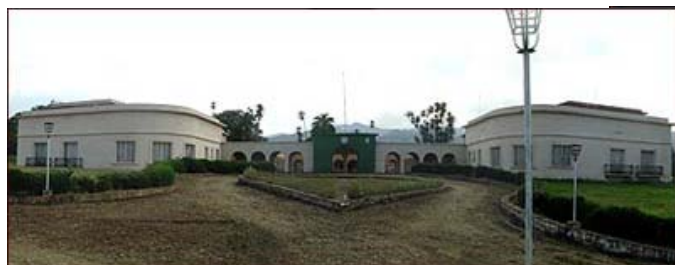
Le bâtiment administratif du CRSN à Lwiro
